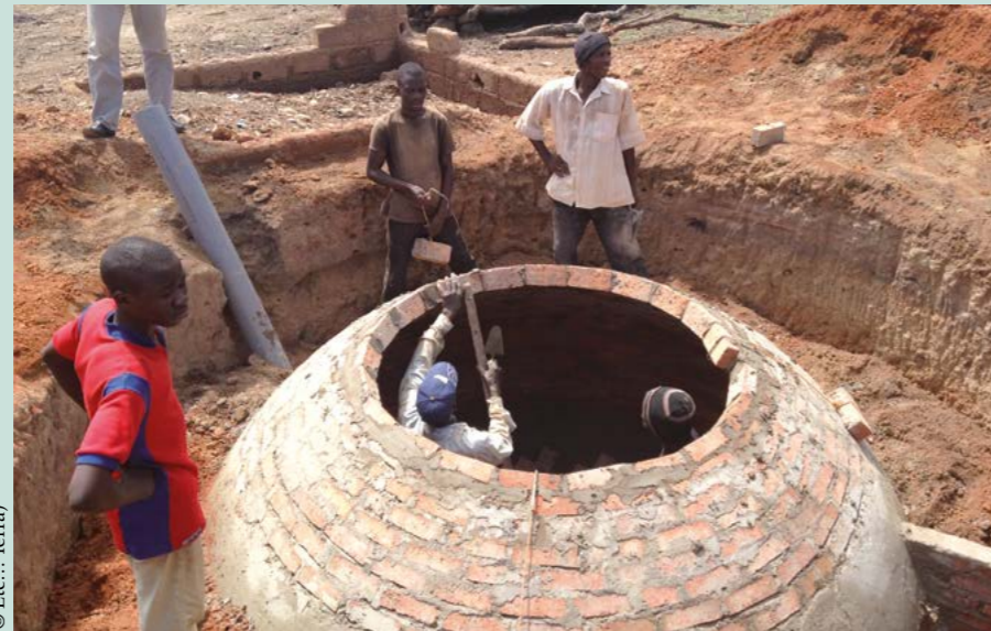
Construction d'un digesteur pour fabriquer du biogaz. Voir le principe et les bénéfices d'un tel projet en scannant le QR-code ci-contre ou https://www.defap.fr/donner/
