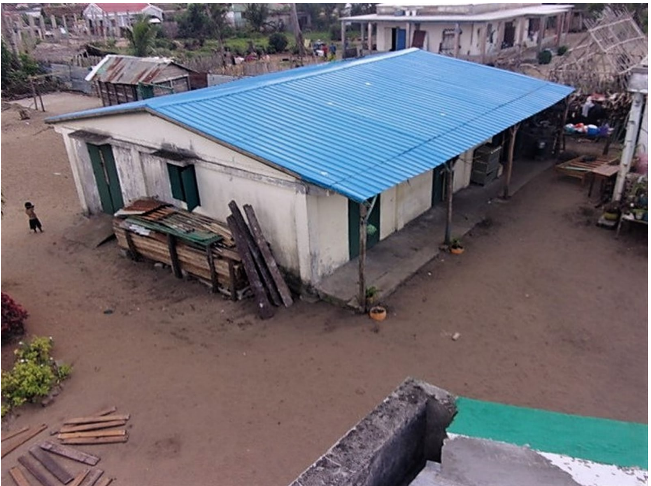
Toitures refaites au centre Akany Fanantenana, à Mananjary © La Cause
