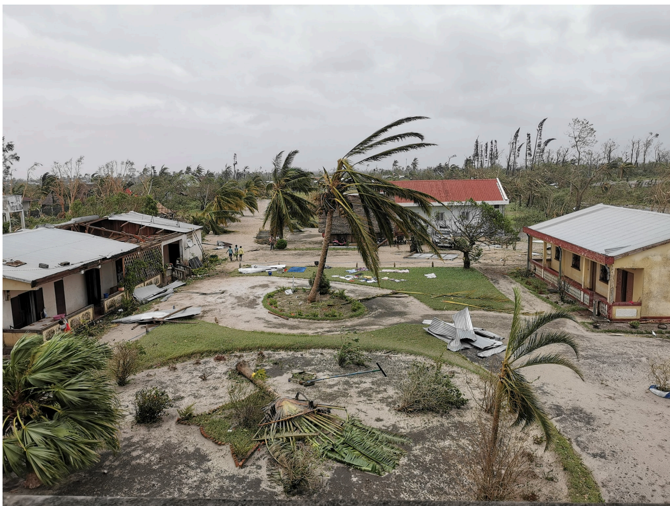
Dégâts du cyclone Batsirai au Catja, à Mananjary © Catja
