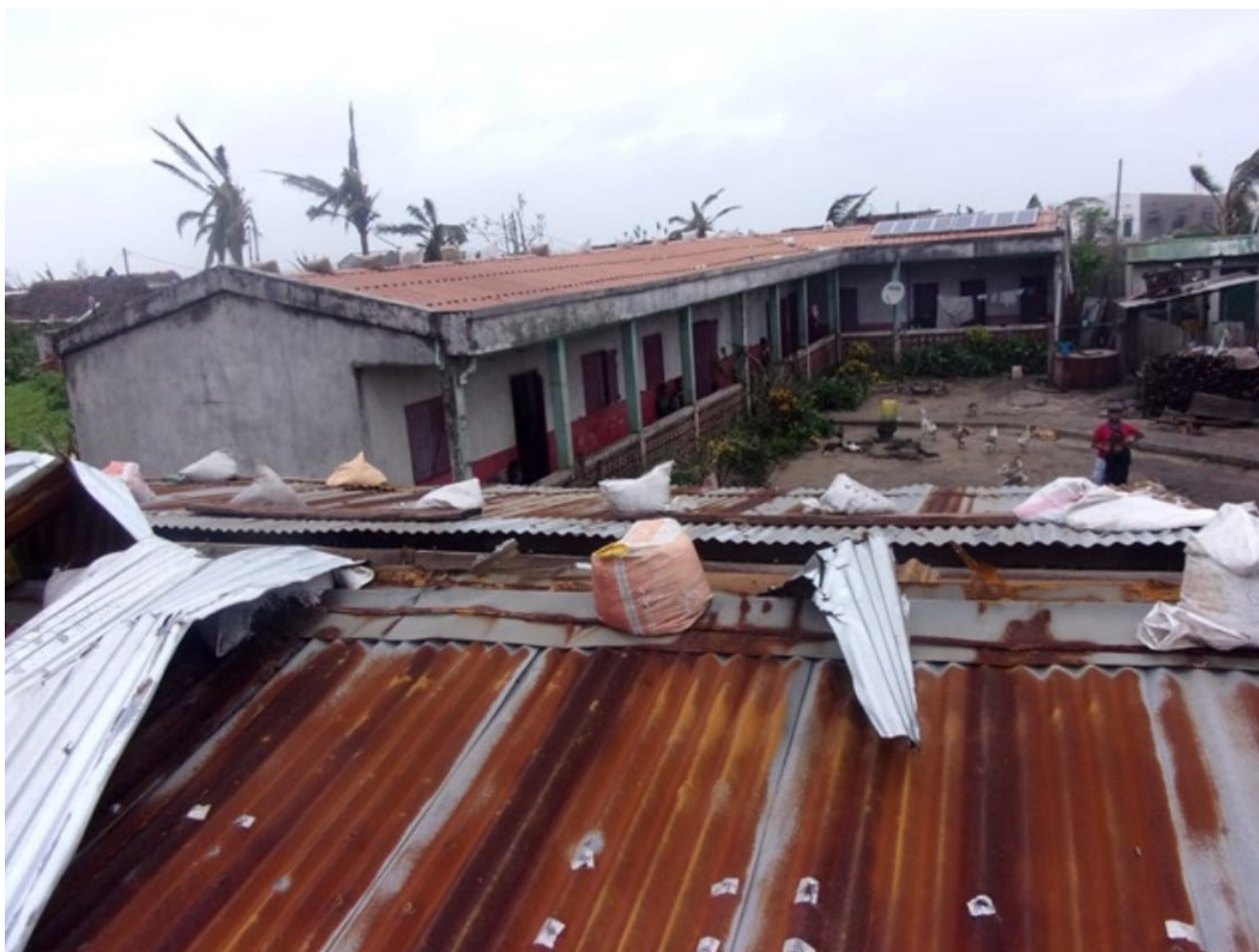
Dégâts du cyclone Batsirai au niveau de la nurserie du centre Akany Fanantenana, à Mananjary © La Cause
