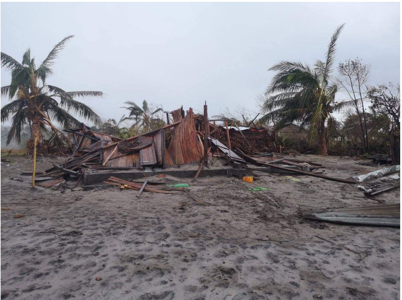
Dégâts du cyclone Batsirai © FJKM
